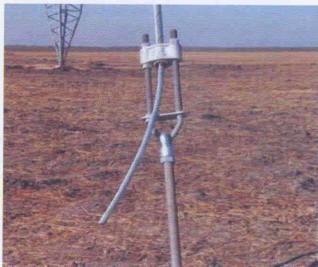
Rienda montada sobre barra de anclaje AIA
