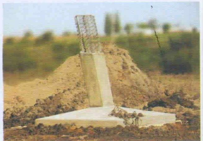
Fundación directa premoldeada para base de mástil antes del montaje
