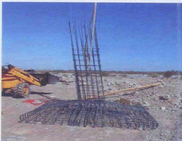
Armadura premoldeada de fundación directa antes del colado in situ
